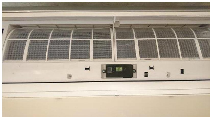
A limpeza deve ser feita com a retirada do filtro, lavando o mesmo com água, sabão e bactericida sem agentes químicos que podem danificar o plástico do elemento filtrante.
